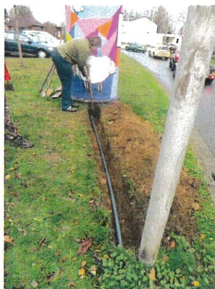
Am 06.12.2018 ergänzte Karl-Heinz Körner die vorbereitenden Arbeiten für den Elektroanschluss, und bracht Bohrungen für die Kabeleinziehung an der Litfaßsäule an und montierte die von ihm bei „amazon“ besorgten LED-Leuchten.
