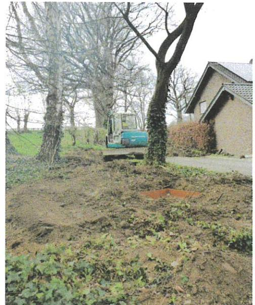
*Mit Fremdhilfe wird das Hauptfundament ausgehoben und ein Stromkabel zum Nachbargebäude verlegt*
