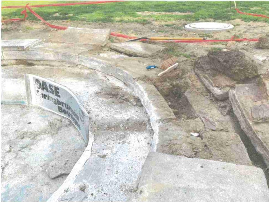
Daher entschloss man sich auch diesen Außenring völlig neu zu befestigen und mit speziellem Material zu verfugen. Diese Arbeiten wurde im April 2021 von Stefan Knob, unterstützt von Guido Schranz und Helmut Frenken durchgeführt erfolgreich abgeschlossen.
