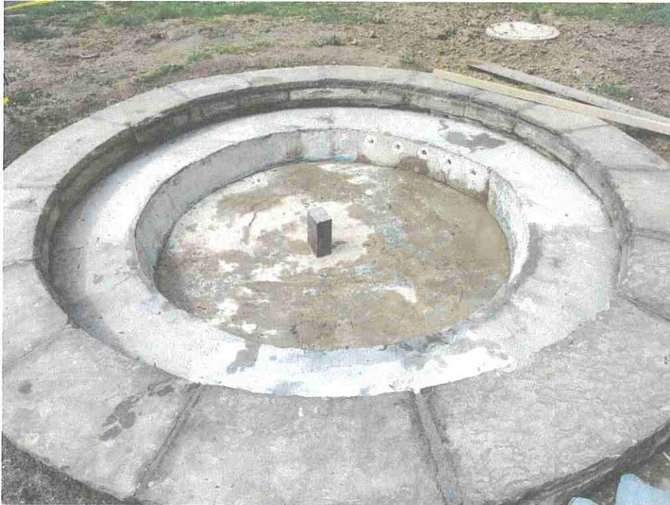
Dazu wurde durch die Steinmetzfirma Rademacher eine Ausgleichsschicht auf die Basis des Innenringes aufgebracht.
