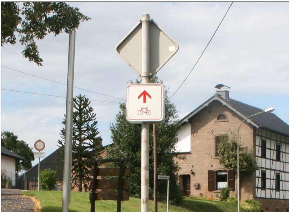
**Bild 11:** Beispielhafte Anbringung eines Zwischenwegweiser (Quelle: Ministerium für Verkehr des Landes Nordrhein-Westfalen [Hrsg.], 2017, HBR NRW)
