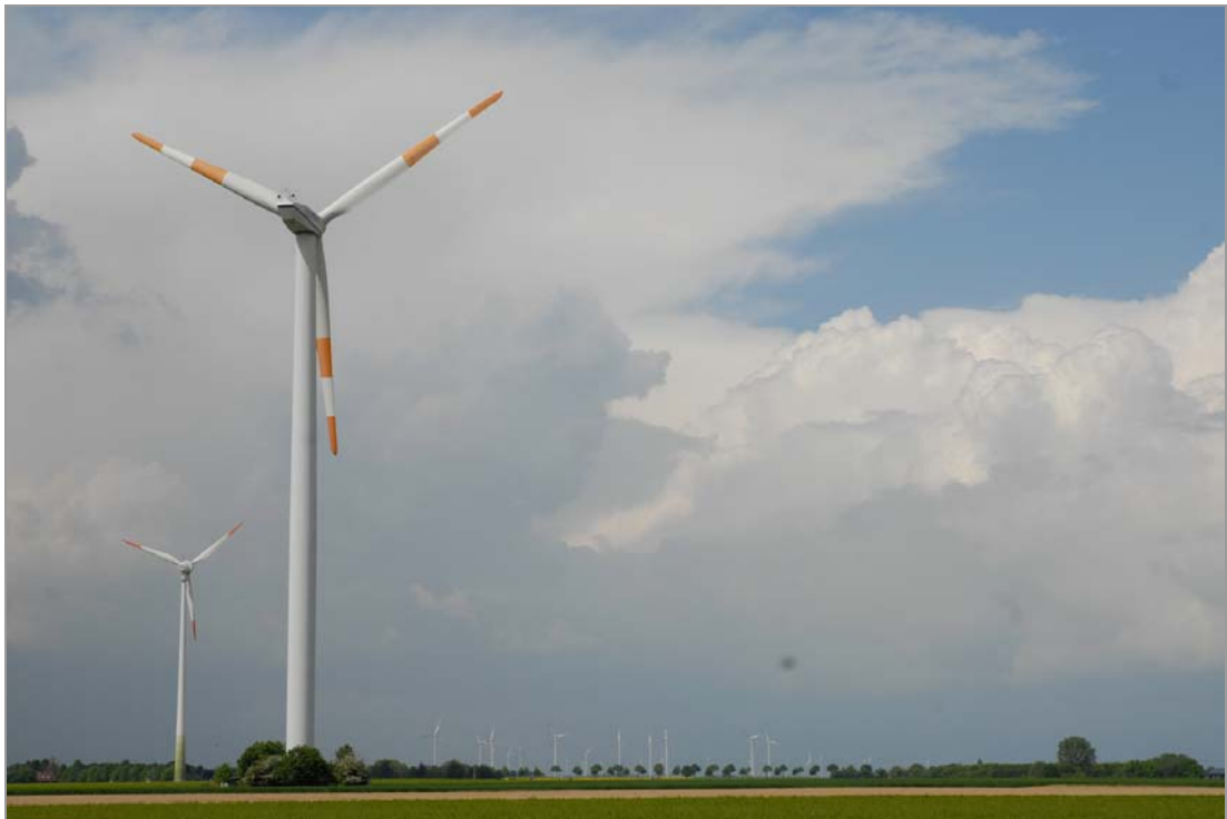
Abb. 5: Ackerlandschaft im Bereich der geplanten Konzentrationszone mit zwei der fünf bestehenden WEA, im Hintergrund Windpark zwischen Bocket / Waldfeucht und Langbroich / Gangelt (Mai 2012)
